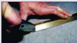
Используя лезвие и нож, нажмите и сделайте надрез или канавку в бетоне.
